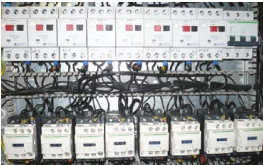
Шкаф автоматизации вентиляционной приточной и вытяжной установки отслеживает температуру обратной воды, наружного и приточного воздуха
