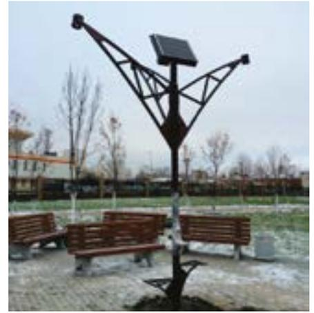
Внутри столба находятся аккумуляторы, которые накапливают энергию от солнечной батареи. Достаточно трех солнечных часов, чтобы фонарь накопил энергии для бесперебойной работы в течение 24 часов. Скоро на фонаре появится беспроводная селфи-камера.
