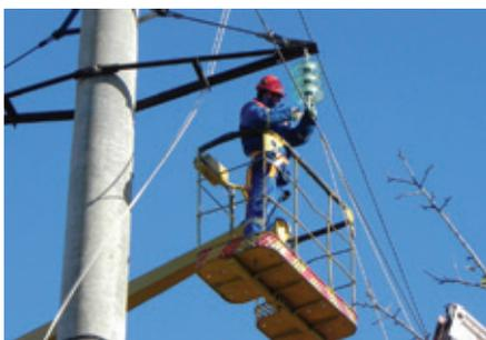
Входящая в группу Россети компания Кубаньэнерго заменила на стеклянные аналоги неисправные полимерные изоляторы на значимых воздушных ЛЭП (линия электропередачи) «Шкуринская-Кушевская» напряжением сто десять киловольт и ЛЭП «Староминская-Шкуринская» такого же класса напряжения.
