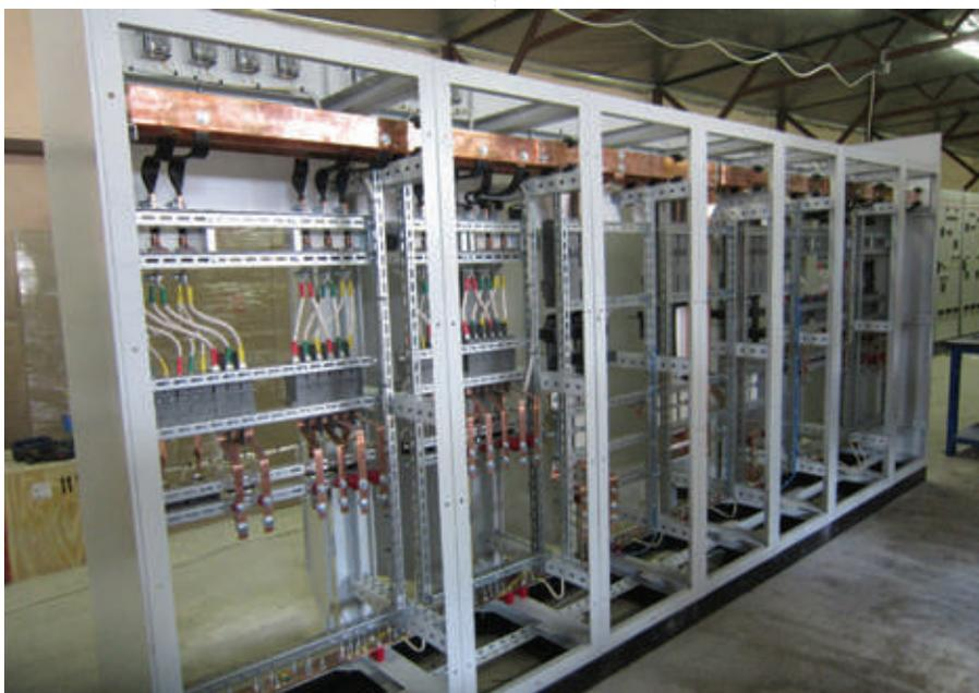
ема и передачи электричества, защиты сети от короткого замыкания и возможных перегрузок, а также для измерения и учета электрической энергии. Оборудование этого типа используется в различных отраслях промышленности для работы с напряжением до 1 кВ переменного тока частотой 50 Гц.
