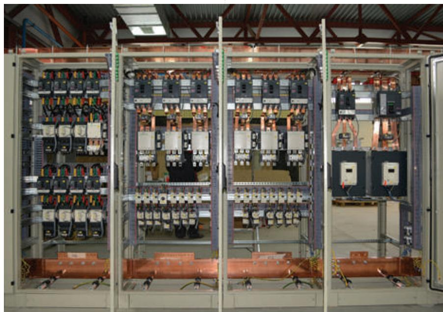
щиты от импульсных перенапряжений, автоматические выключатели и устройства дифференциального тока) и узел учета электроэнергии. Довольно часто счетчик устанавливается на вводной панели. Он обеспечивает контроль энергопотребления непосредственно на первом от сети коммутационном устройстве.
