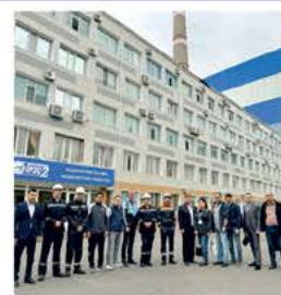
АО «Станция Экибастузская ГРЭС-2»
