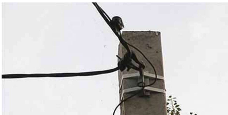
Рисунок 4. Узел угловой промежуточной опоры ВЛИ.
