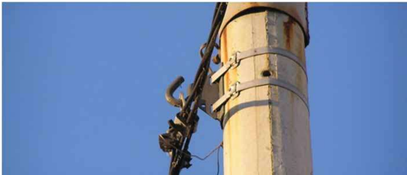
Рисунок 5. Узел промежуточной опоры.
