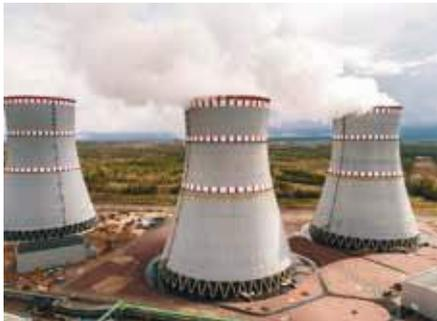
В июне на энергоблоке № 6 с реактором ВВЭР-1200 второй очереди Ленинградской АЭС завершились последние и самые экстремальные испытания, предвещающие физический пуск, – «горячая» обкатка реакторной установки. Специалисты полностью отключили штатное электропитание собственных нужд блока и протестировали работу его технологических систем и систем безопасности в смоделированных условиях.
