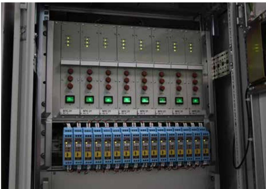
В отличие от электромеханических реле цифровые защитные устройства имеют широкий диапазон уставок и потому не требуют модификаций с разнообразными диапазонами измерения входных аналоговых сигналов.
