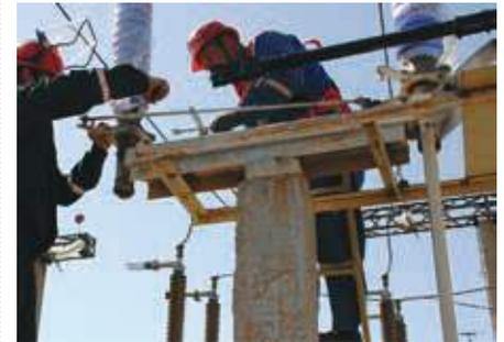
Филиал «Россети Волга» (бренд ПАО «МРСК Волги») – «Оренбургэнерго» проводит второй этап реконструкции ПС 110/35/10 кВ «Сельская». Энергетики меняют отслужившие срок отделители и короткозамкватели на блоки с современными элегазовыми выключателями, а также открытое распределительное устройство 35, 110 кВ – на ячейки с элегазовыми выключателями.
