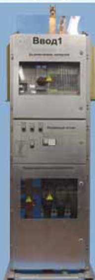
АВР-0,4-1250-ОТМ на выключателях АBB
