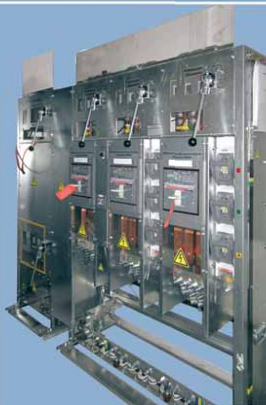
ЩРНВ комбинированный с автоматическими выключателями, фидерами АBB и ОСР
