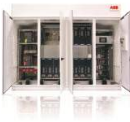
Рис. 7. Устройство хранения энергии.
