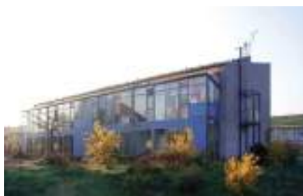
Рис. 1. Северный фасад пассивного дома в г. Дармштадте, р-н Кранихштайн.
