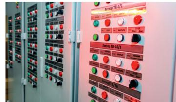
**Низковольтные комплектные устройства (НКУ) серии ШУН-01Р.** Предназначены для применения в составе ПТК, для управления в местном и/или дистанционном; в ручном и/или автоматическом режимах нагрузками различного назначения (электроприводами трубопроводной арматуры; электродвигателями; электронагревательным и осветительным оборудованием и т.п.).
