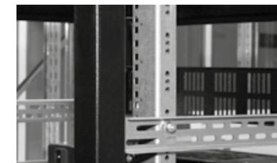
На монтажные профили нанесены метки, обозначающие высоту каждого юнита
