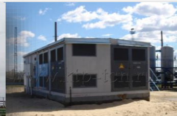
в бетонной оболочке
