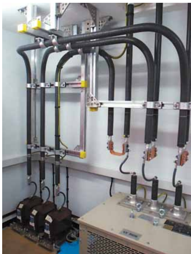
Подключение измерительных трансформаторов к линии токопровода
