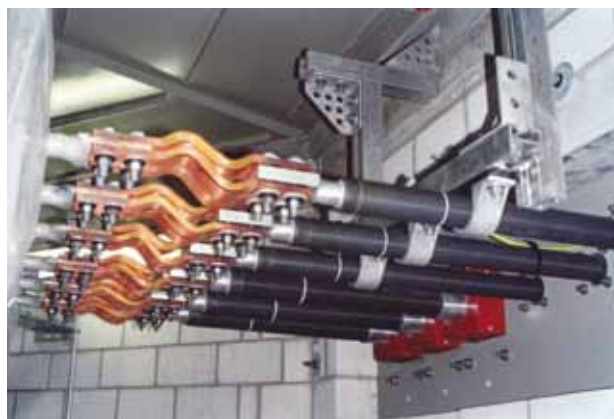
DURESCA 7,2 кВ 1600 А Подключение токопровода шинными компенсаторами
