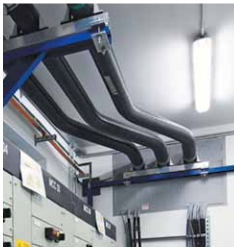
DURESCA 12 кВ 3150 А Проход через стену
