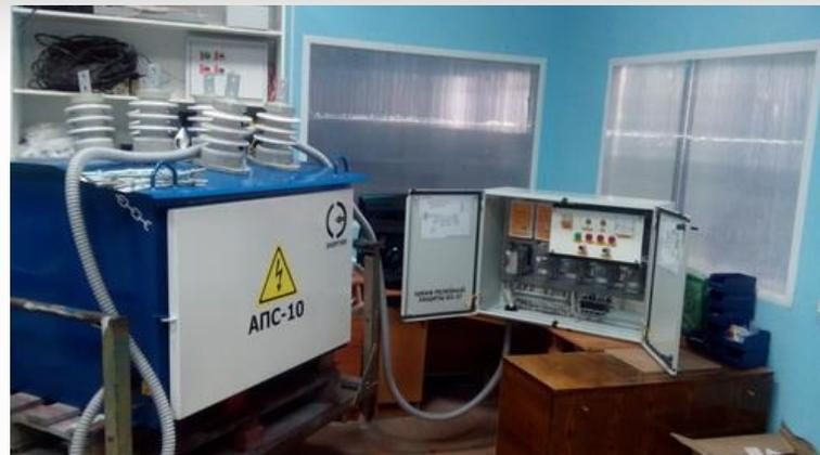
Автоматический пункт секционирования (вакуумный реклоузер) - это коммутирующее устройство на основе вакуумного выключателя, выполняющее функцию автоматического отключения отрезка (секции) линии электропередачи в случае возникновения перегрузки (например, короткого замыкания) в этой секции.
