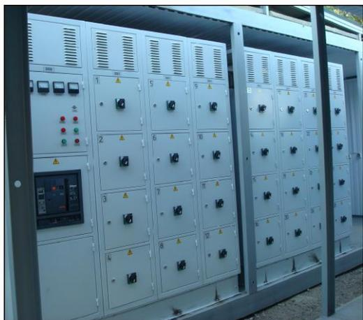
НКУ серии РУНН-0,4 предназначены для распределения электрической энергии, защиты электрических установок при перегрузках и токов коротких замыканий, и для нечастых включений - отключений электрических цепей. РУНН-0,4 изготавливаются в виде щитов двустороннего обслуживания ячейечного типа, с выдвижными автоматическими выключателями и подразделяются на шкафы ввода ШНВ, шкафы секционирования ШНС, шкафы линейные ШНЛ, шкафы резервного ввода от дизельгенератора ШНД.
