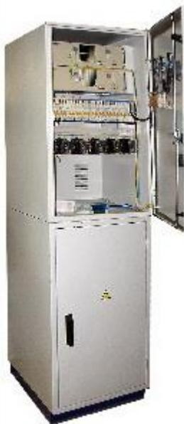
Шкаф оперативного постоянного тока (ШОТ) предназначен для преобразования электрической энергии переменного тока от одного или двух независимых источников, в электрическую энергию постоянного тока, распределения электрической энергии по цепям собственных нужд постоянного тока, бесперебойного снабжения оперативных цепей постоянного тока (напряжением 220В) в распределительных устройствах, системах аварийного питания, освещения и пр.
