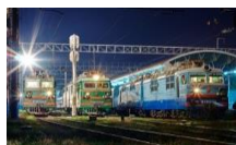
Модернизация системы освещения объектов железнодорожного транспорта Казахстана
