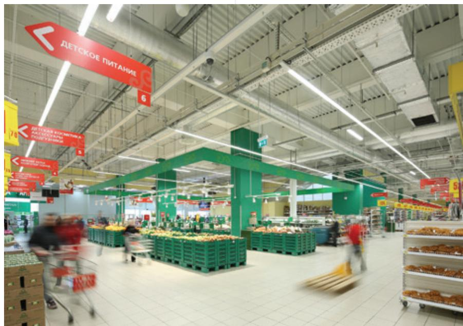
вещения в торговом зале гипермаркета до 800 Лк. При этом осветительные приборы обеспечивают необходимый запас освещенности при диммировании: в некоторых отделах, в случае 20% приглушения яркости, уровень освещения достигает 1000 Лк.
