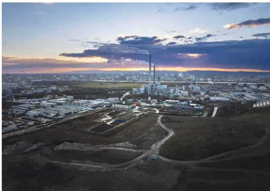
В настоящее время установленная электрическая мощность станции составляет 24,8 МВт, тепловая – 157,5 Гкал/час.
