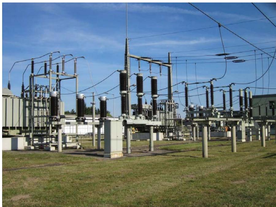
1. Маслонаполненные электротрансформаторы относятся к категории пожароопасных. При использовании такого оборудования необходимо строго соблюдать технику безопасности из-за возможности возгорания. Агрегаты нельзя устанавливать вблизи от взрывоопасных предметов и открытого огня, необходимо постоянно следить за утечкой масла.
