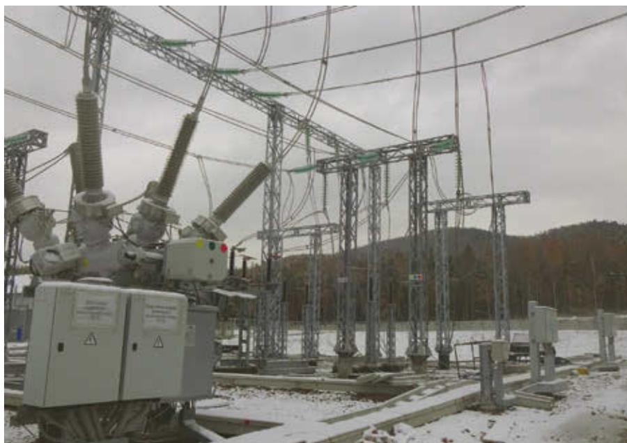
и составляет 525 МВА. На энергогенерирующем объекте установлен новый выключатель 220 кВ, разъединители 110 и 220 кВ, три ячейки 10 кВ, регистраторы аварийных событий, а также автоматическая система сбора и передачи информации. Помимо этого, построен маслосборник вместимостью 500 м<sup>3</sup> и заменены защиты автотрансформатора, ограничители перенапряжения, выключатель 110 кВ, трансформатор собственных нужд.
